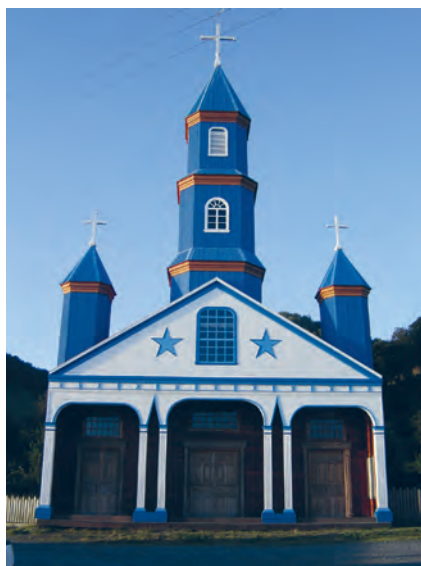
Figura 3: Iglesia Chiloé Tenaún.
